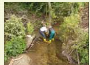
Einbau von Totholz im Hilgenbach (2008)
