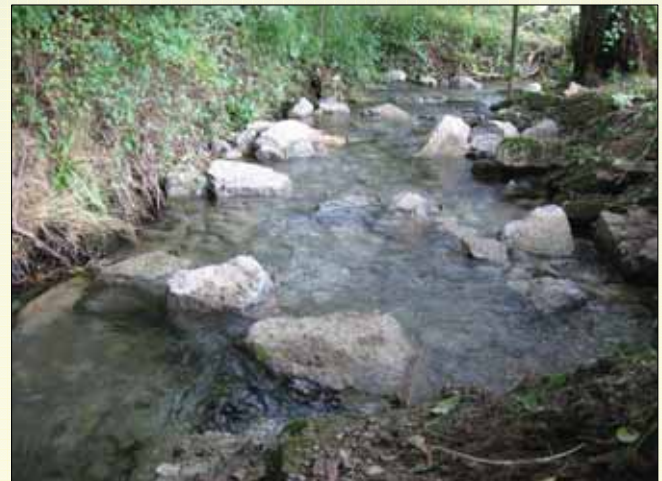
Fertiggestellte Sohlgleite an der Schelpe (August 2008) mit strömungsberuhigten Ruhezeiten in den Randbereichen
