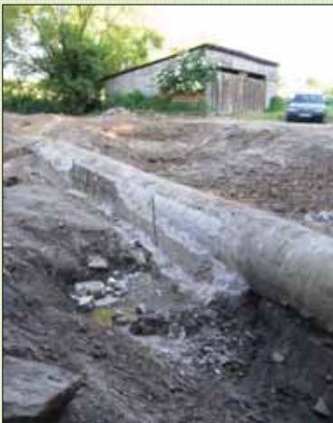
Entfernung eines verrohrten Gewässerabschnittes am Lomborn südlich von Fürstenau (Juni 2008)
