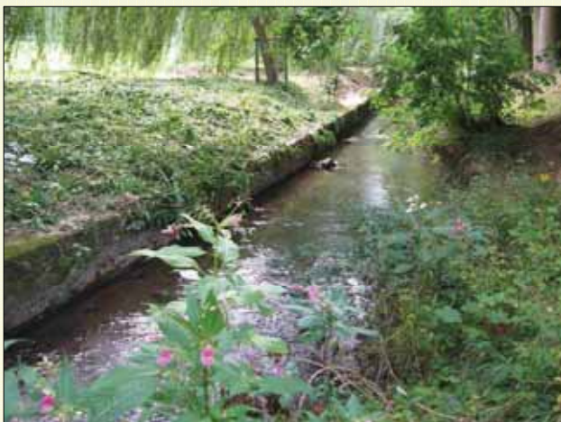
Ufermauer der Brucht (Kaiwasser) im Stadtgebiet Brakel (Juni 2008)
