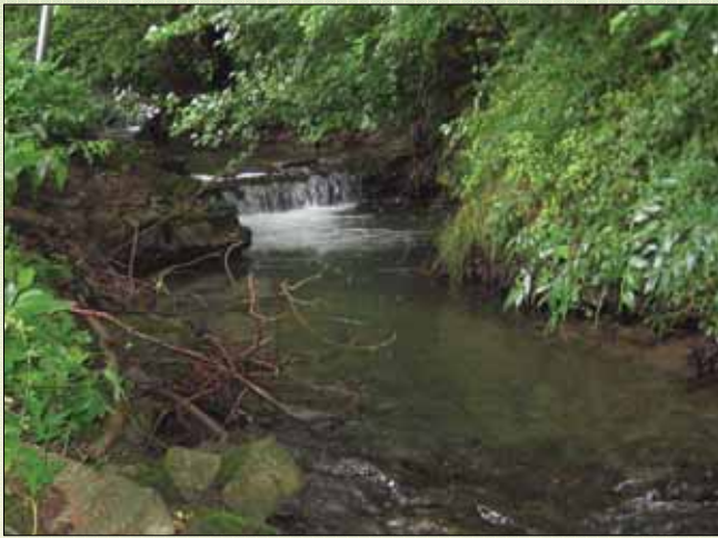
Sohlabbsturz eines ehemaligen Wehres (Grüne Mühle) an der Schelpe (Juni 2008)
