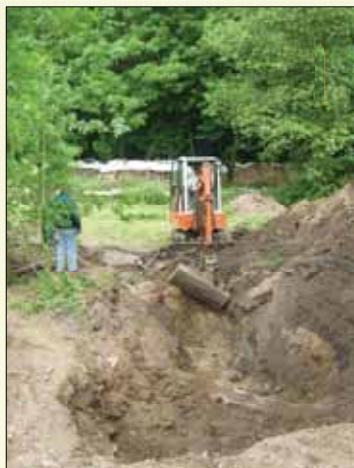
Strukturierung des neuen Gewässerbettes
