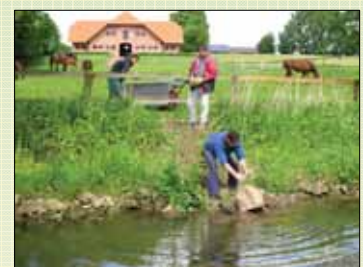
Einbau von Steinen als Strömunglenker und Fischunterstand an der Eggel (2009)
